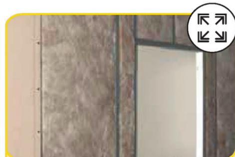
Полностью заполняет металлический профиль без щелей и зазоров благодаря повышенной упругости и ширине плит 610 мм.
