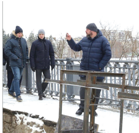
Советник Сергей Лежнев ведёт губернатора Андрея Клычкова и осуждённого директора ООО «Ремспецмост» Евгения Подрезова на мост «Дружба»
