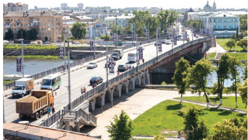
«Красный мост» в Орле до ремонта
