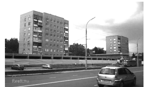
Разрушающийся объект «Океан»
