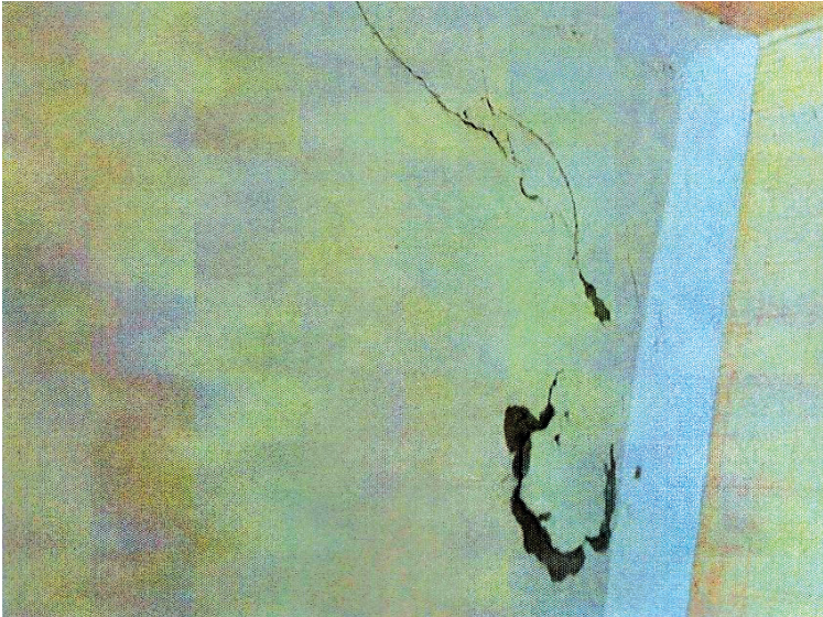
Трещина над аркой в коридоре напротив входной двери
