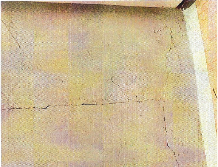
Трещина над аркой в коридоре напротив туалета
